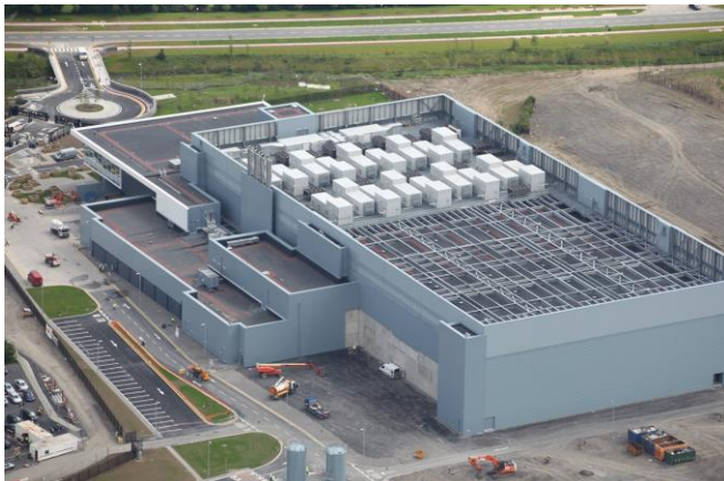
ЦОД Вконтакте Санкт-Петербург
