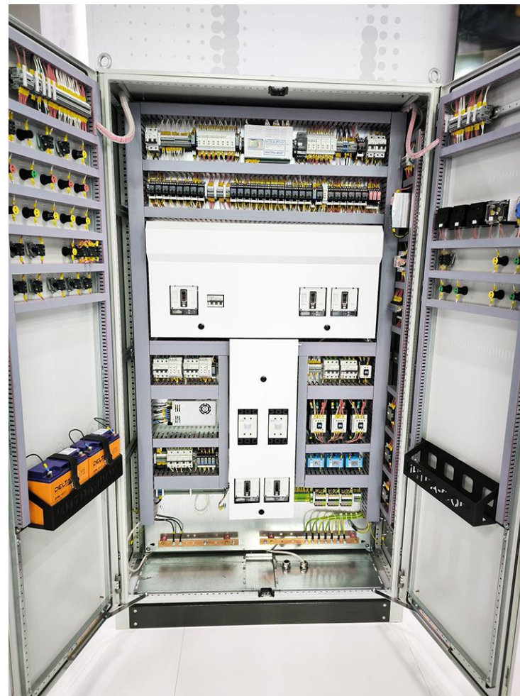
Шкаф управления насосами автоматической установки пожаротушения «Интра-Фог»
