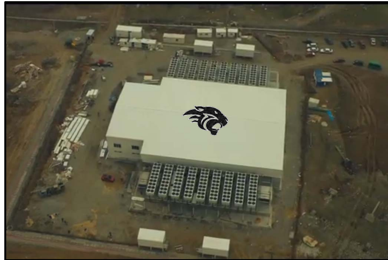
ЦОД BitFury, 40MW, 2-ф погружное охлаждение с Noves™ 7100, 35 кВт/м 2
