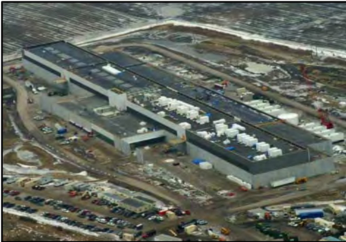
ЦОД Facebook, ~40MW, воздушное охлаждение, 3 кВт/м 2
