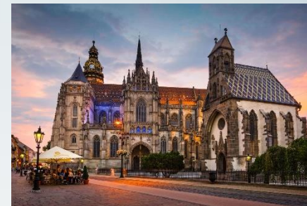
Кошице, Словакия, Мини-ЦОД муниципалитета
