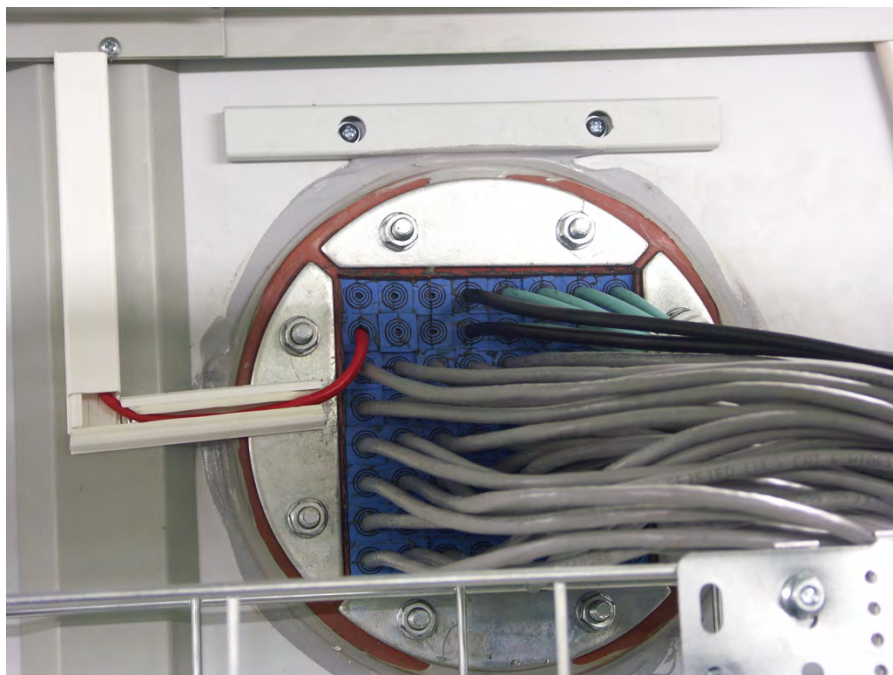
Прокладка коаксиальных и оптоволоконных кабелей
